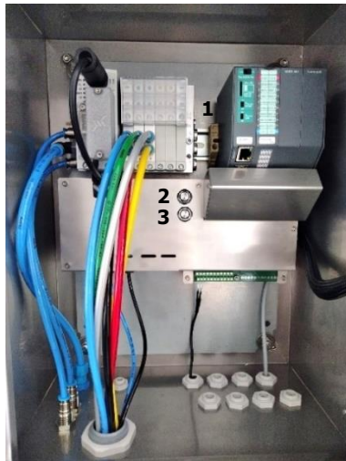
Abb. 2: Armaturensteuerung innen (mit bzw. ohne Display)
